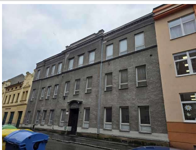
Čelní/východní fasáda-z ul. Zákřejsovy
