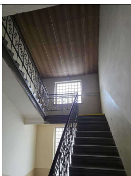
Schodiště do půdního prostoru
