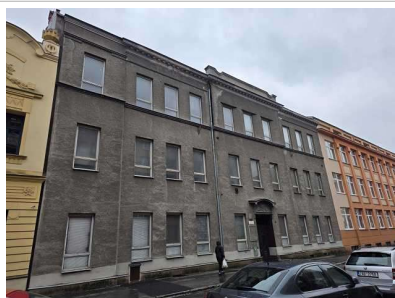
Čelní/východní fasáda- z ul. Zákřejsovy
